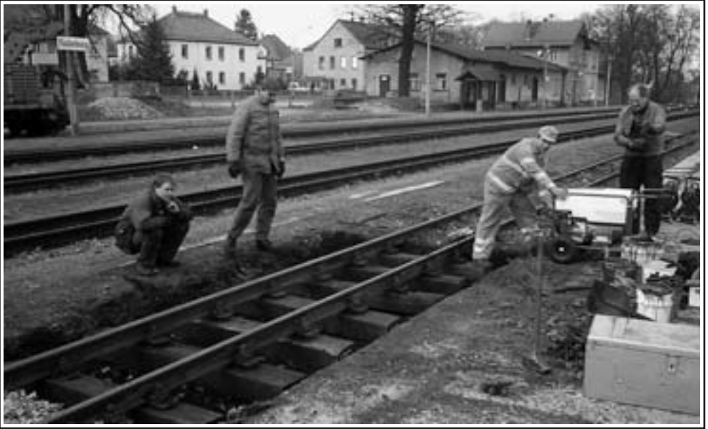
Schwellenwechsel auf Gleis 5 in Radeburg: Nichts für Weicheier... Fotos: R. Fischer
