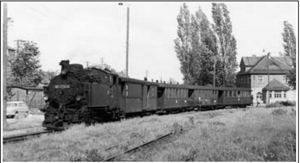
Alltagsbetrieb in Kesselsdorf für 99 713: Kurz vor Stilllegung bespannte sie 1972 einen Personenzug von Freital-Potschappel nach Nossen. Foto: Sammlung Fritz-Hager-Archiv
