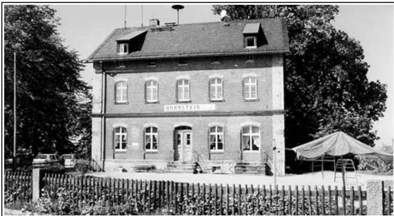
Das Empfangsgebäude in Hohnstein entstand in dem für die Zeit um 1895 typischen Klinkerbaustil. Foto: A. Kroß
