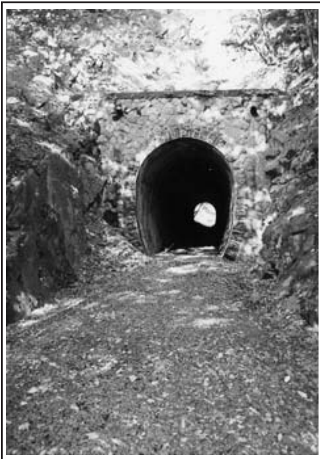
Der untere Tunnel bei Goßdorf-Kohlmühle. Foto: A. Kroß
